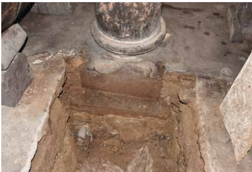
Abb. 11: Kloster Eberbach, Infirmariehalle. Die bauzeitlichen Säulenbasen mit Eckzier sind aufgrund des neuzeitlich eingebrachten Betonestrichs nicht sichtbar. Foto: Christine Krienke, LfDH, 2016
