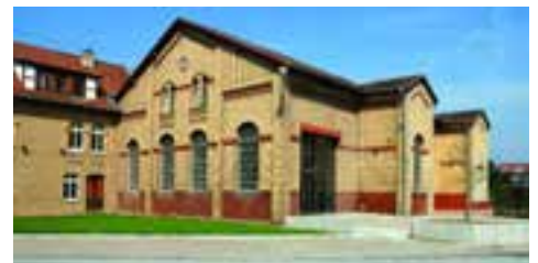
Eschwege, E-Werk Mangelgasse 19 (1)
