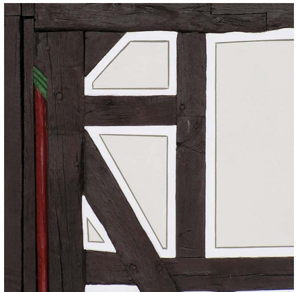
Anstrich auf Fachwerk
