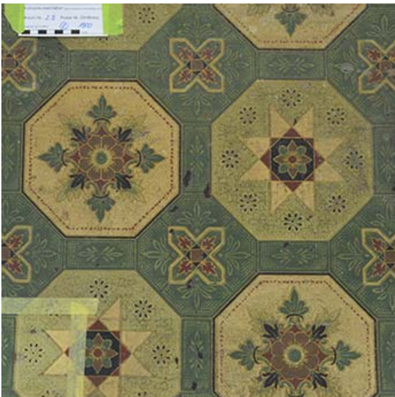
Instandsetzung und Restaurierung von historischem Linoleum Fußbodenbelag
