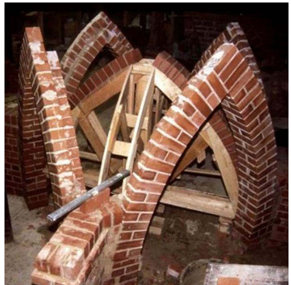
Bögen, Gewölbe und Strebepfeiler
